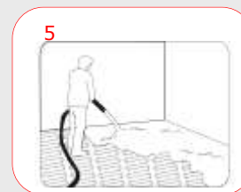
Verser sur la trame une couche de ciment auto-nivellant
